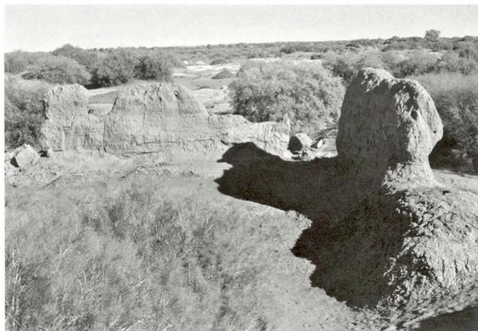
图二一 K688 古城墙体东南角
